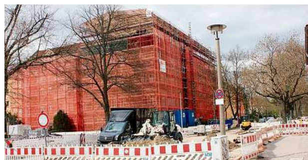
Am Knotenpunkt Schönstraße/Große Seestraße gehen die Arbeiten in die Endphase. Ende Mai wird die Baustelle beräumt. Foto: Bernd Wähler
